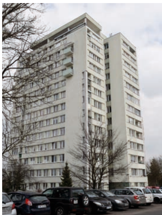
1. Efekty modernizacji przegród zewnętrznych budynku Bernardyńska 20 (dla porównania po prawej bliźniaczka budynku nie poddany termomodernizacji)
