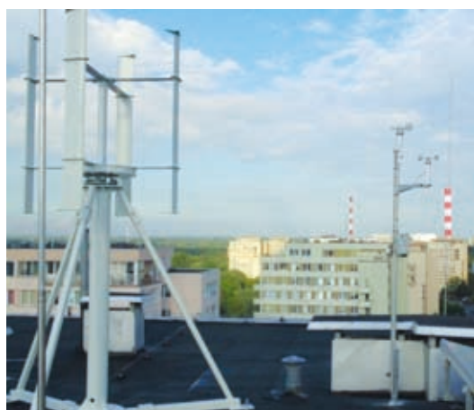
7. Widok na instalację wiatrową
