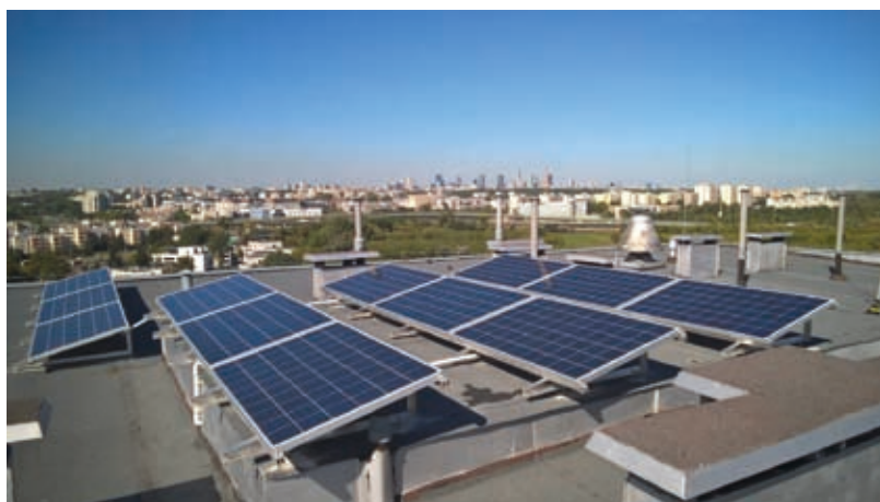
5. Panele fotowoltaiczne na dachu budynku.
