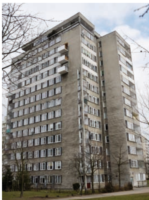
1. Efekty modernizacji przegród zewnętrznych budynku Bernardyńska 20 (dla porównania po prawej bliźniaczka budynku nie poddany termomodernizacji)
